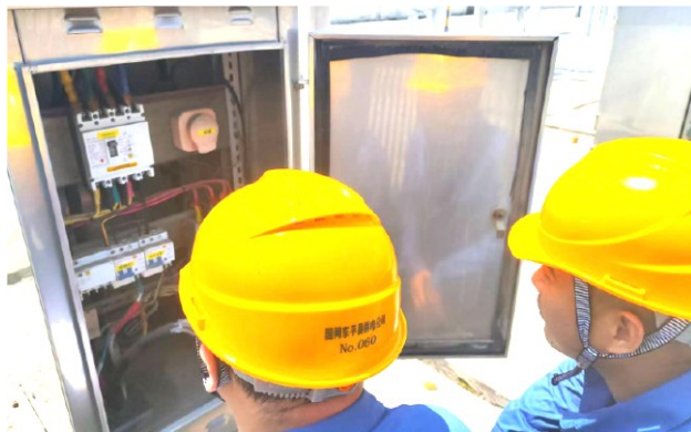
图3 变电站二次巡检现场
